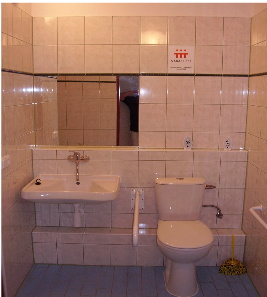
Stavební úprava bezbariérového sociálního zařízení
