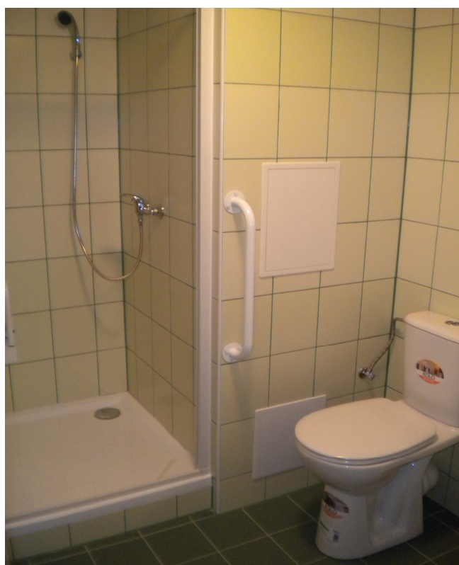
Garsoniéra (stavební opravy pokoje a sociálního zařízení)
